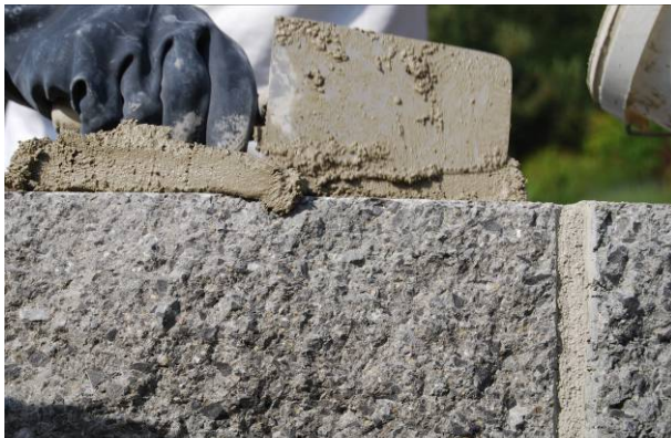
Bild 62: Erstellen der Mörtelvorlage
