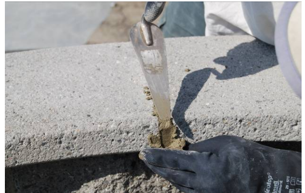
Bild 64: Verfugen der Abdeckplatten
