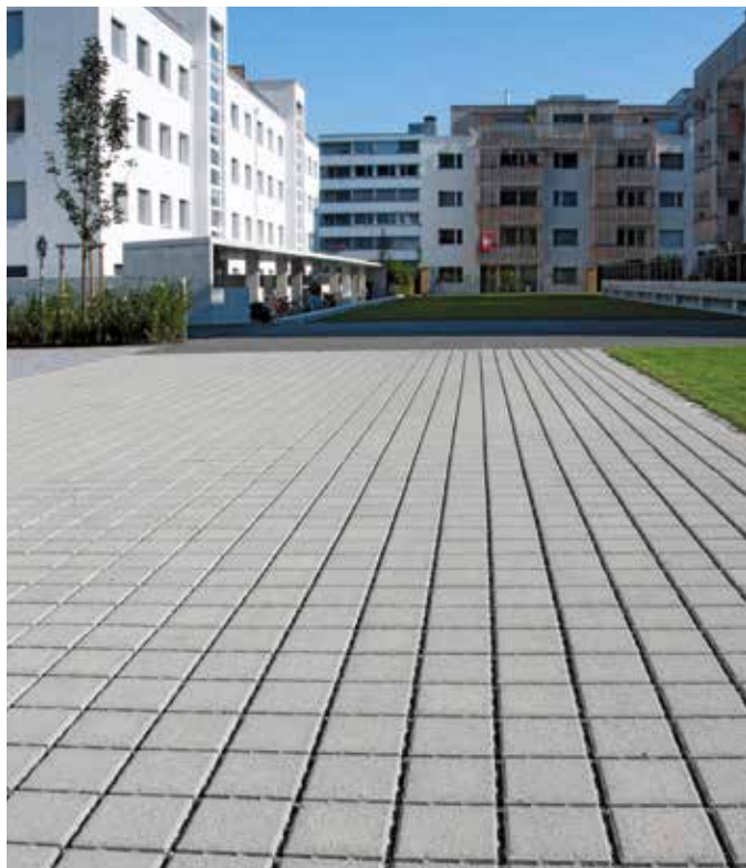
Parkfläche mit SPLITT Ökosteine
