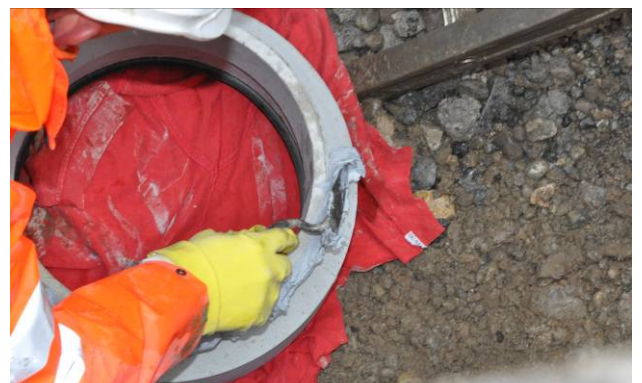
Bild 9: Auftragen der Klebmasse auf den Schaft
