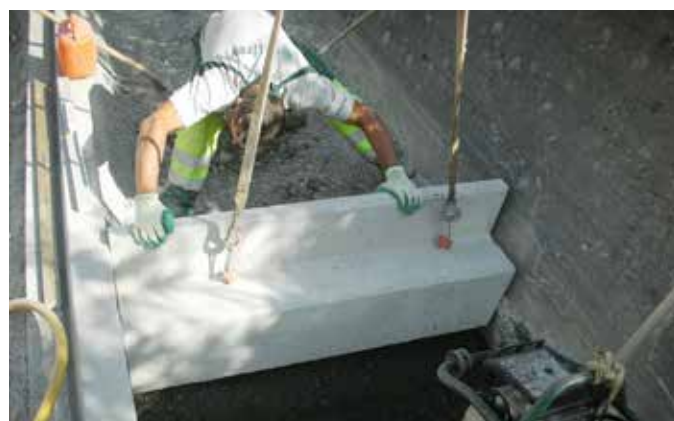
Versetzen des F+F Fertigfundamentes
