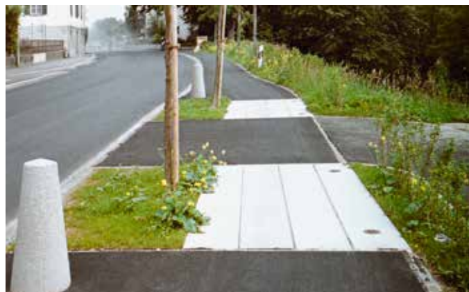
Wurzelbrücke mit Wehrsteinen als Anfahrtschutz
