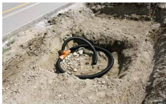
Vorbereitete Sickerrohre in der Baumgrube
