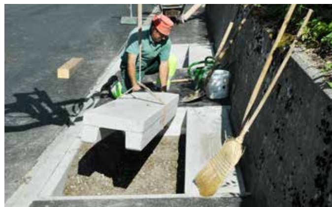
Versetzen der F+F Abdeckelemente
