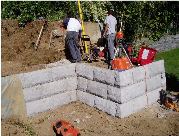
Bild 45: Innenecke mit Gehrungsschnitt und Aussenecke
