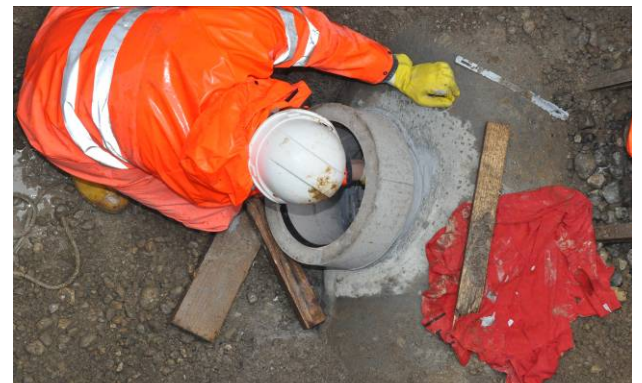
Bild 12: Innenkante von Hand modellieren und Reste entfernen
