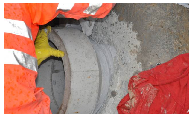
Bild 13: Bilden der äusseren Kehlkannte
