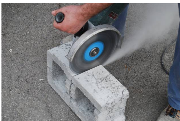
Bild 52: Trennen der Spaltsteine mit Winkelschleifer
