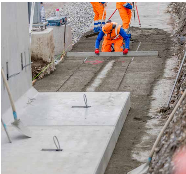
Pose des éléments sur semelle filante
