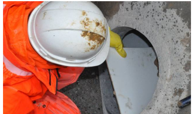
Bild 8: Einlegen einer Unterlage
