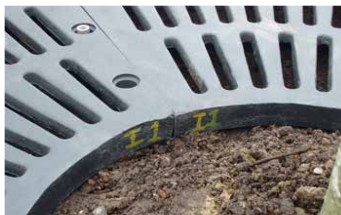
Einfaches Zusammensetzen des 4-teiligen Gussrostes mit den zusammengehörenden Markierungen
