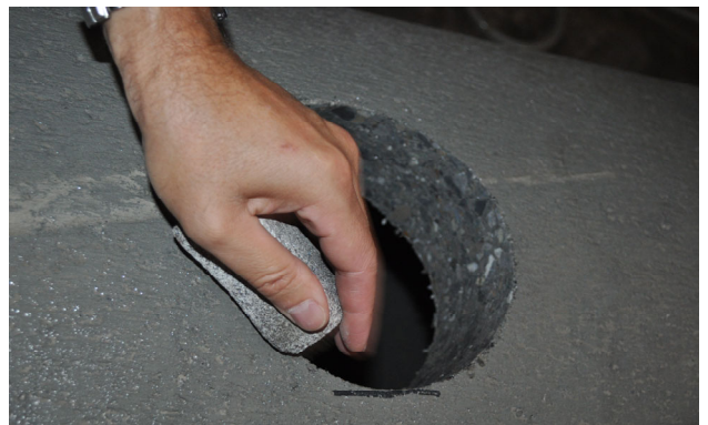
Bild 7: Bohrlochkante abrunden und Bohrloch reinigen
