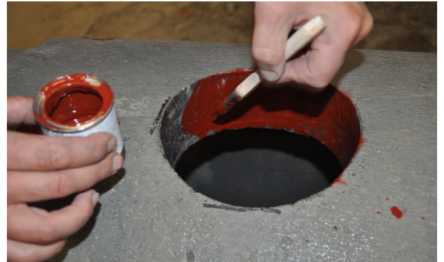
Bild 10: Auftragen von DENSONOX GV auf Bohrlochwandung
