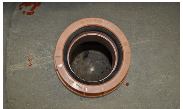
Bild 13: Keilgleitdichtung und Spitzende mit Gleitmittel einschmieren
