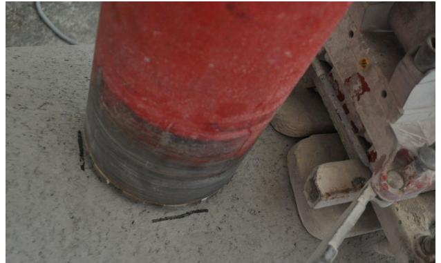
Bild 6: Korrekt montiertes Kernbohrgerät
