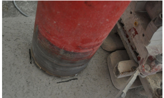
Bild 6: Korrekt montiertes Kernbohrgerät
