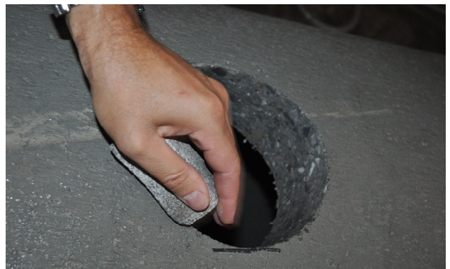
Bild 7: Bohrlochkante abrunden und Bohrloch reinigen
