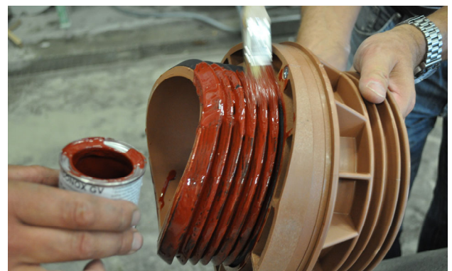
Bild 9: Auftragen von DENSONOX GV auf Dichtungsmanschette
