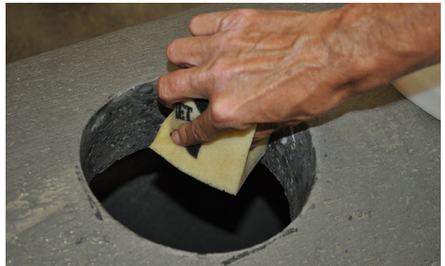
Bild 8: Bohrlochwandung mit Wasser befeuchten
