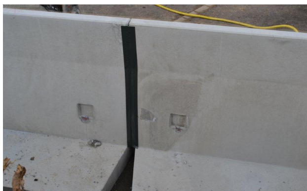
Bild 40: Abdichten der Fugen
