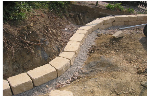
Bild 24: Versetzte erste Steinreihe in Kiesfundament
