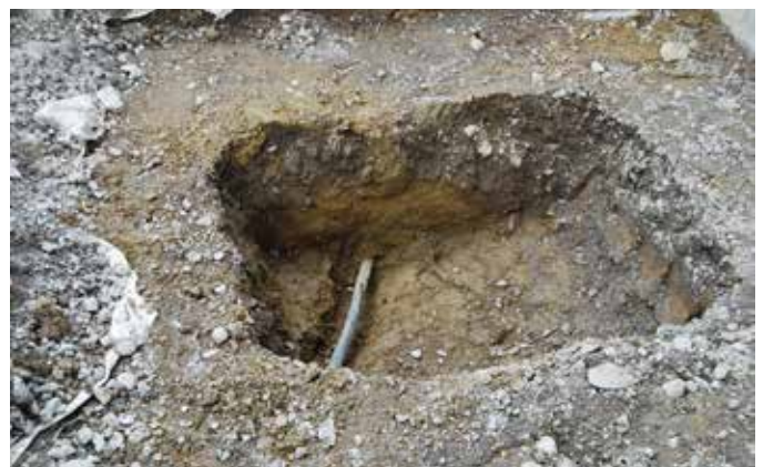
Werkleitungen stören das Wachstum der Baumwurzel
