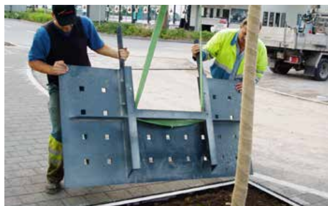
Transport der COPAL STEEL Stahlbaumscheibe
