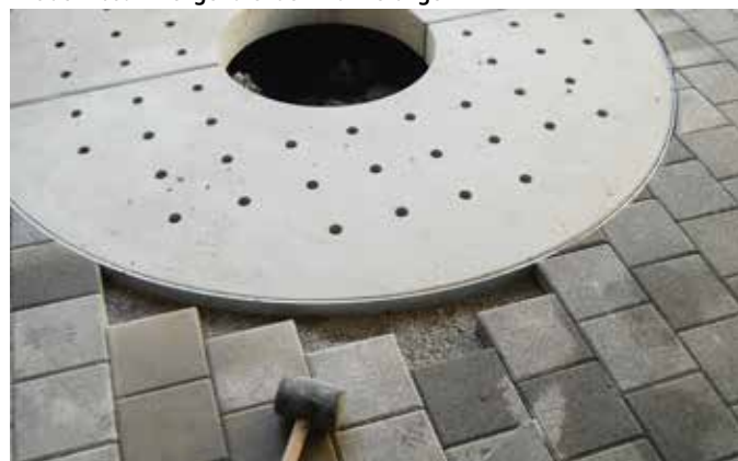
Versetzte TREETUB Betonabdeckung 2-teilig
