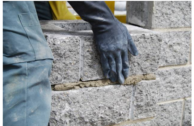
Bild 59: Versetzen von Pfeilerspaltsteinen
