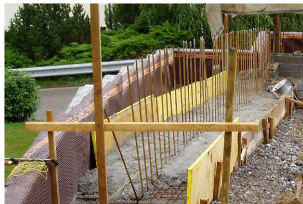
Bild 35: Fundament mit Anschlussbewehrung
