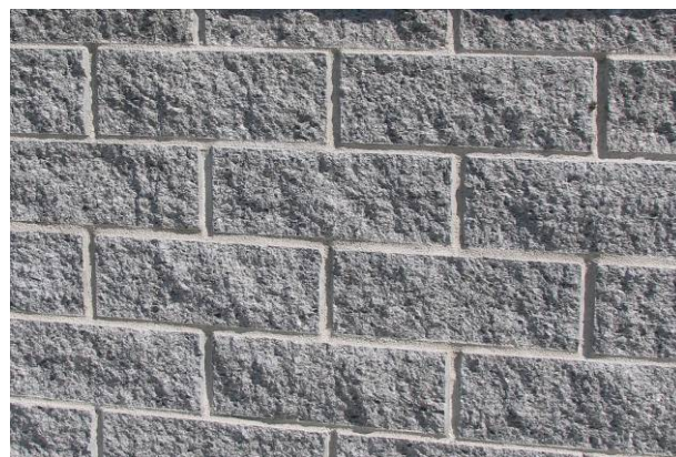
Bild 5: Oberfläche der Spaltsteine, grau mit Splittkorn
