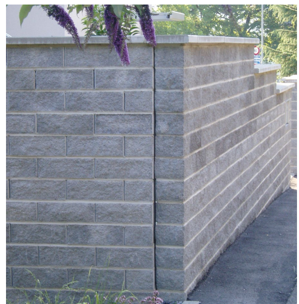
Bild 41: Dilationsfuge (Produktneutral)
