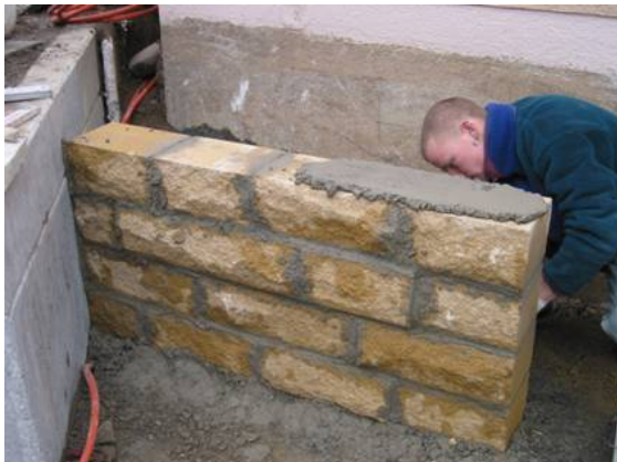
Bild 42 Aufbringen Mörtel für Abdeckplatte
