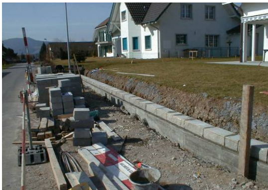
Bild 23: Versetzte erste Steinreihe in Betonfundament
