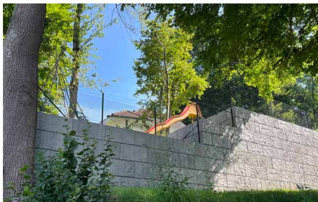
Illustration 1 : éléments de talus FELSMAUER pour la consolidation de talus
