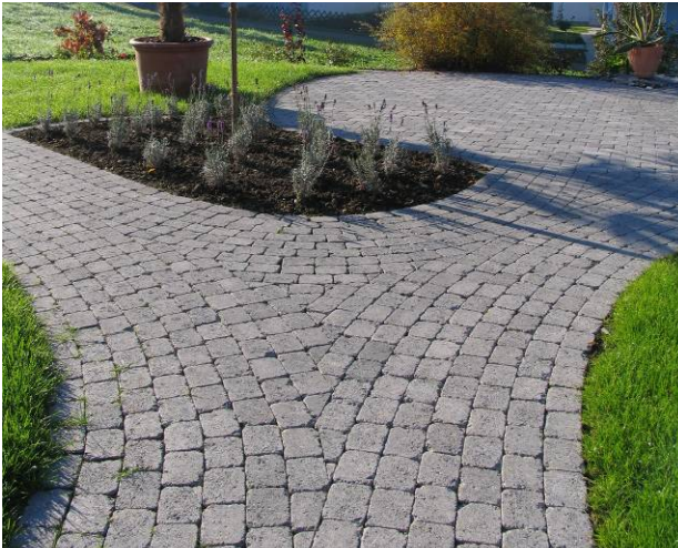
Bild 41: Pflasterfläche mit Passsteinen
