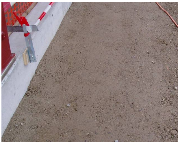
Bild 32: Eingebaute verdichtete Fundationsschicht
