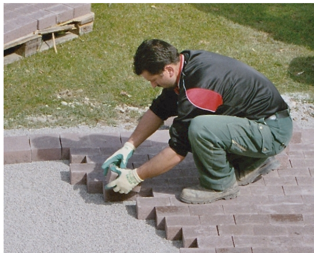
Bild 35: Verlegung der Steine von Hand
