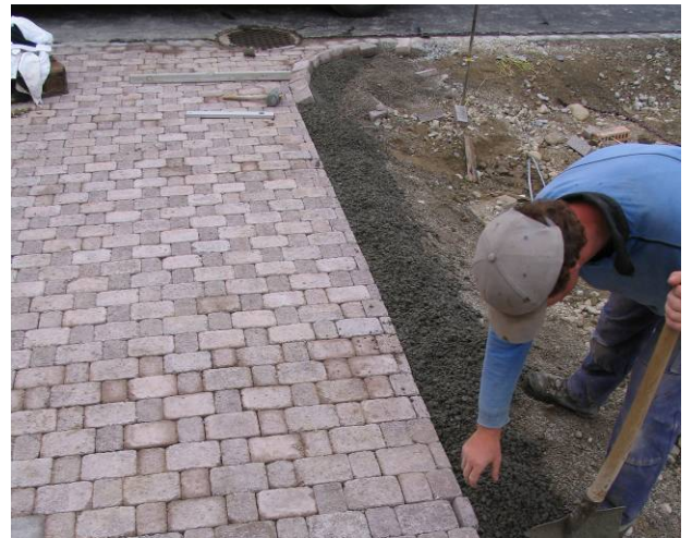
Bild 43: Erstellen des Randabschlusses
