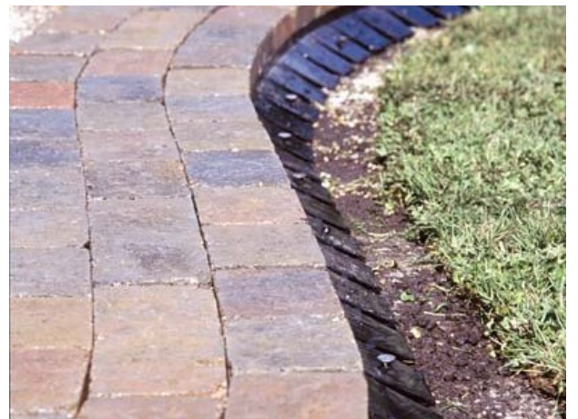
Bild 44: Randabschluss mit PAVE EDGE Randschienen
