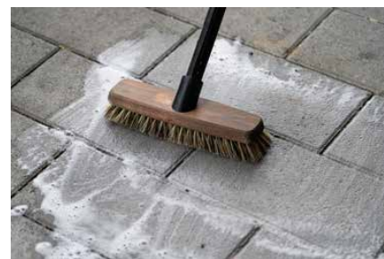
Application du produit de nettoyage
