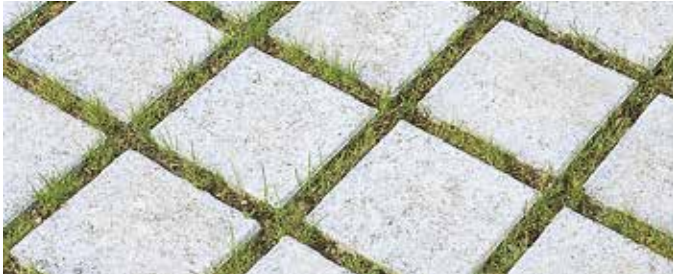
Versickerung durch aufgeweitete Fugen (Rasenfuge)
