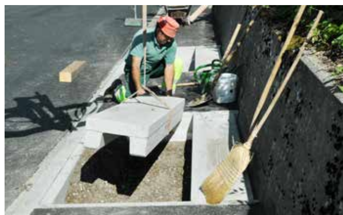
Versetzen der F+F Abdeckelemente
