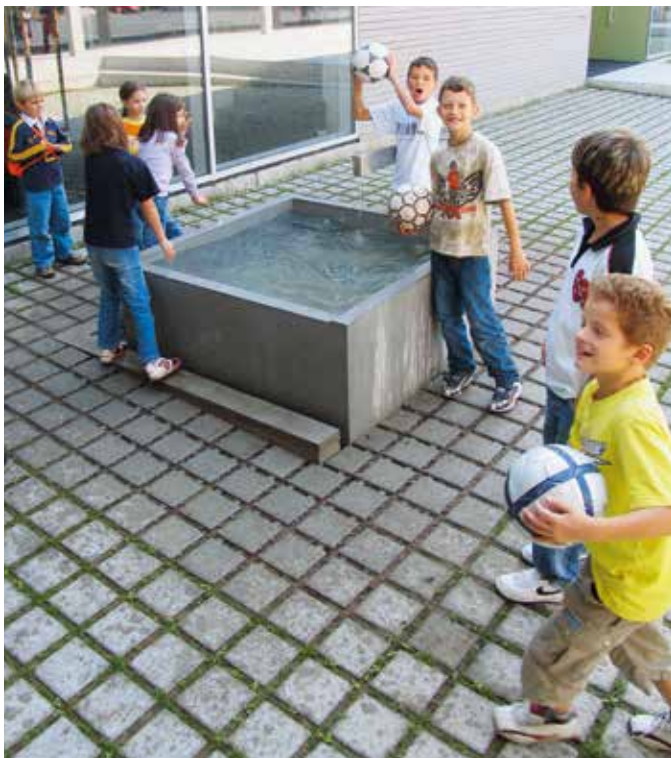
Pausenplatz mit Rasenfugenstein
