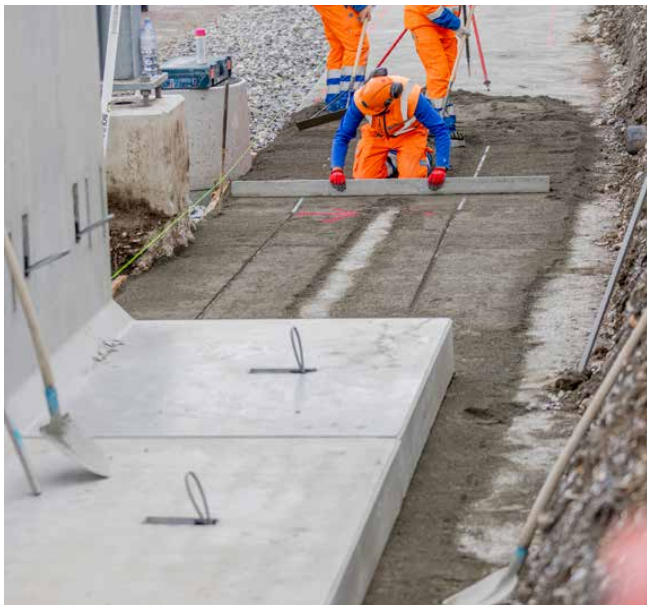
Pose des éléments sur semelle filante
