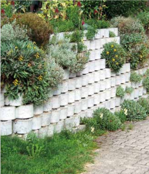
Begrünbare (offene) Hangsicherung
