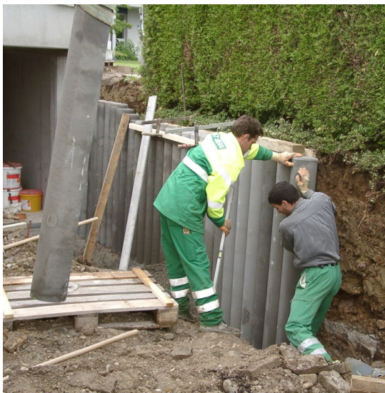
Bild 12: Versetzen und Richten von Palisaden
