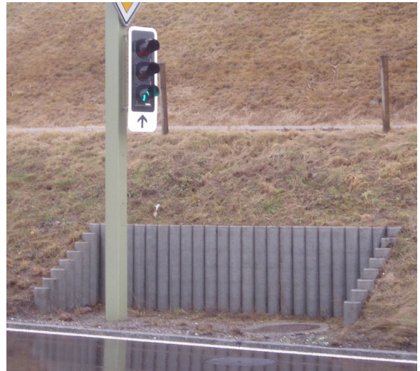
Bild 4: Palisaden als Hangsicherung
