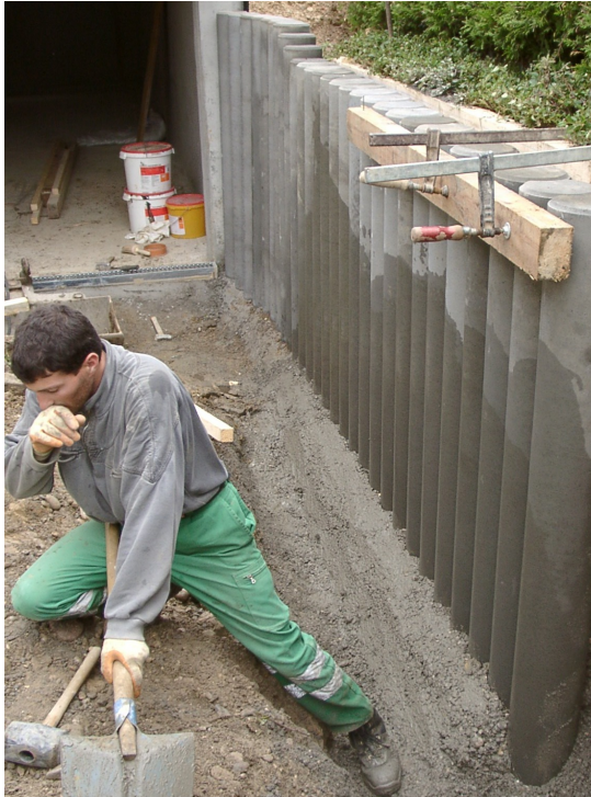
Bild 15: Einbetonieren der Palisaden
