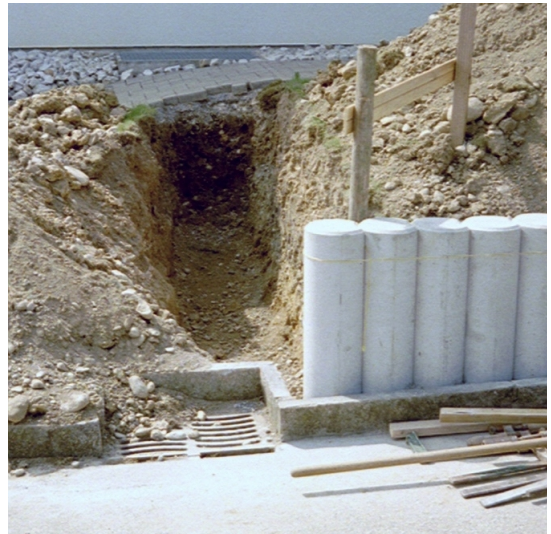
Bild 8: Aushub für Streifenfundament
