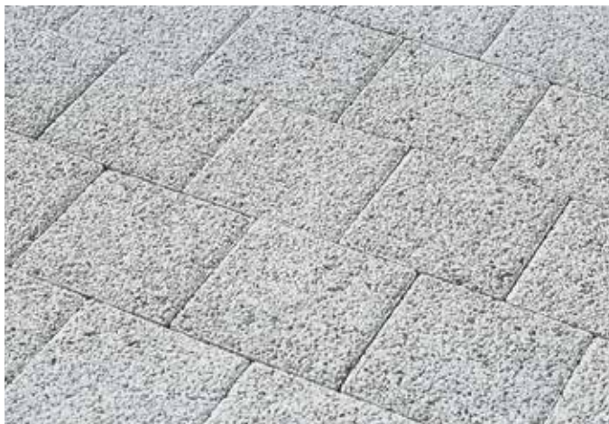
Wasserdurchlässiger Pflasterstein (Sickerstein)
