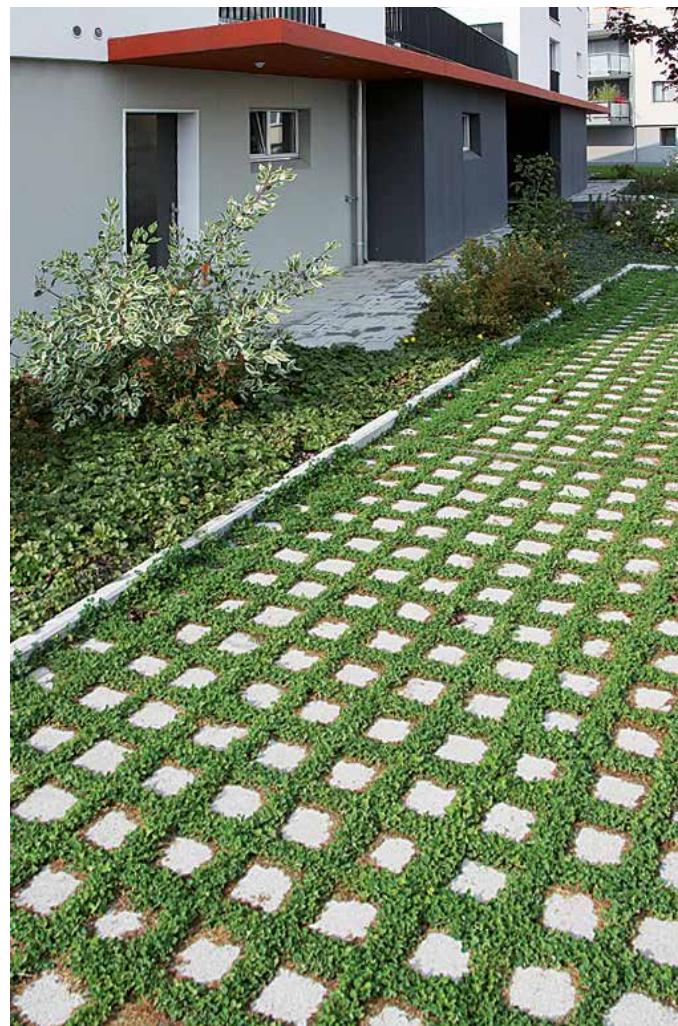
Parkfläche mit CLASSIC® Rasenfuge
