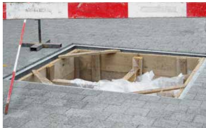
Pflanzengrube mit Fundament und Stahlrahmen
