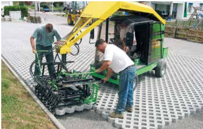
Maschinelles Verlegen mit OPTIMAS-Verlegemaschine
