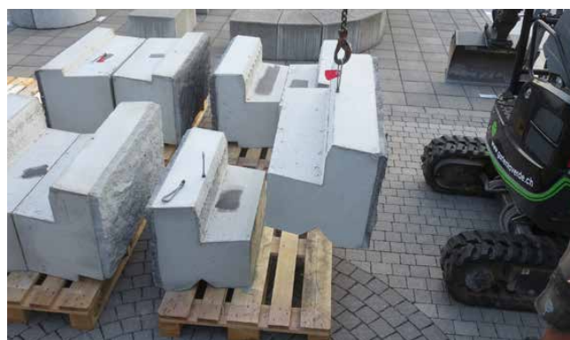
Illustration 21 : douilles de transport M16 montées en usine
