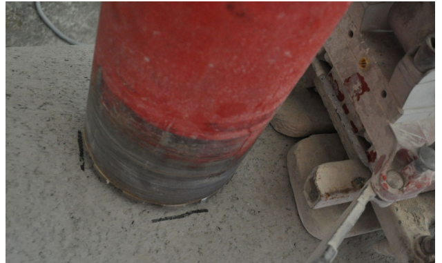
Bild 6: Korrekt montiertes Kernbohrgerät
