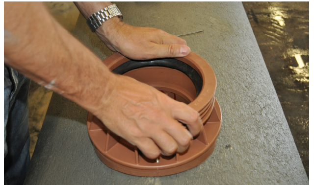
Bild 12: Steckanschlussstück einpressen
