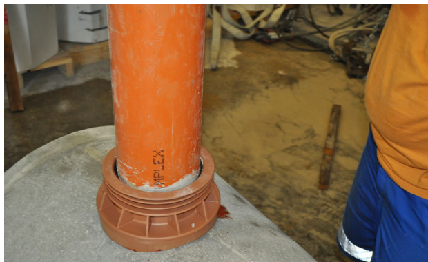
Bild 14: Anschlussrohr anschliessen
