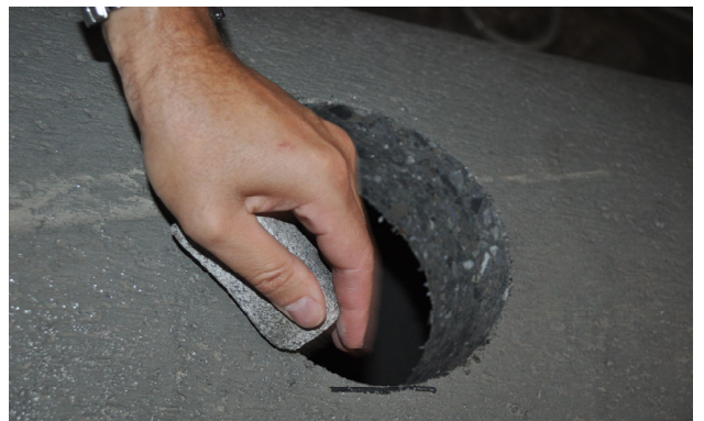
Bild 7: Bohrlochkante abrunden und Bohrloch reinigen
