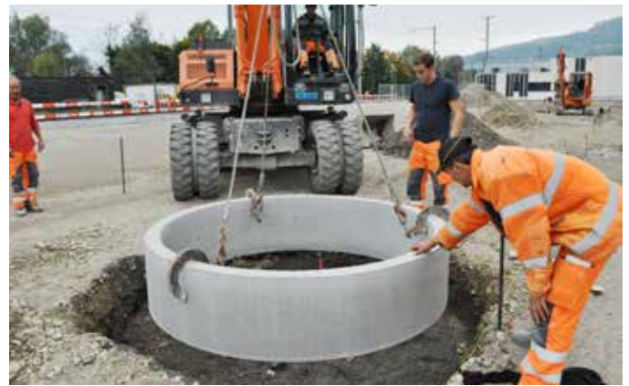
Versetzen des TREETUB Betonrohres auf das Streifenfundament
