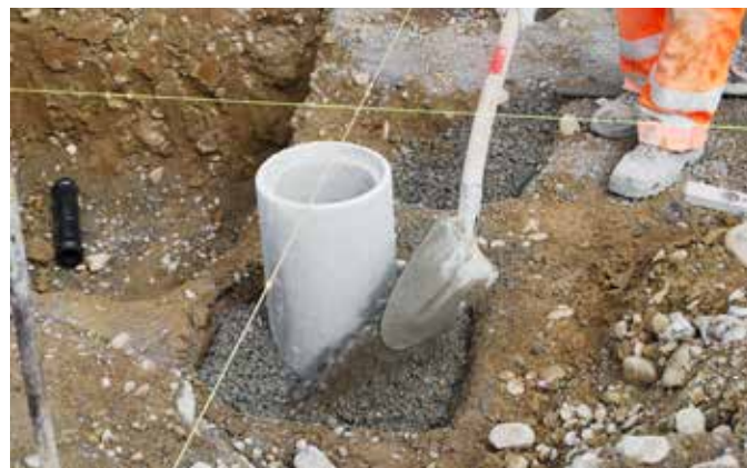
Erstellen der Punktaulager mit Betonrohren
