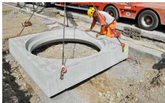
Versetzen des COPAL QUADRO Baselementes
