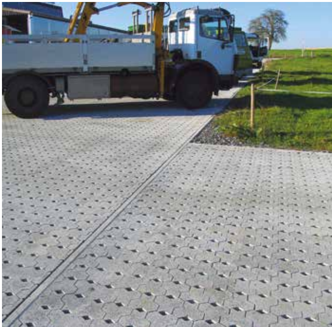
Parkfläche mit SIX SILENTA Ökosteine (Splittfugen)
