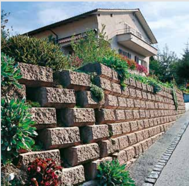
Böschungselemente mit Längsgefälle
