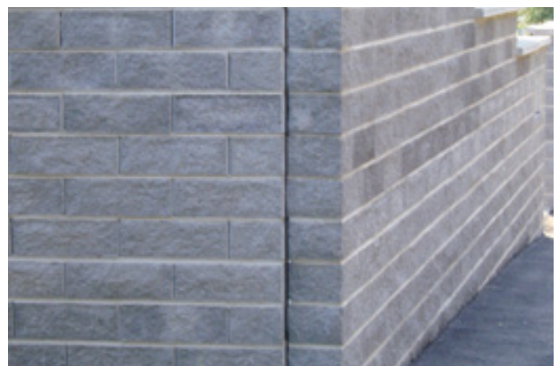
Bild 56: Vertikale Dilatationsfuge bei einer Eckausbildung
