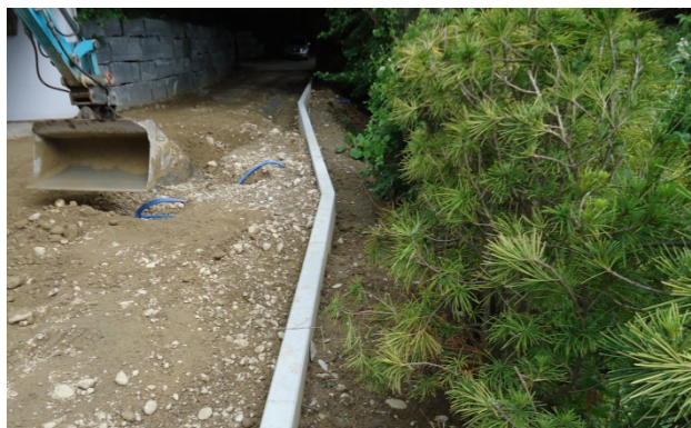
Bild 41: Lagenweises Einbringen von geeigneten Hinterfüllmaterial
