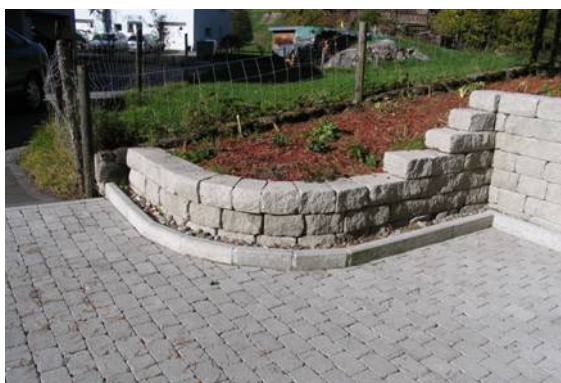
Bild 30: Maueraufbau mit SANTURO® Keilmauersteinen
