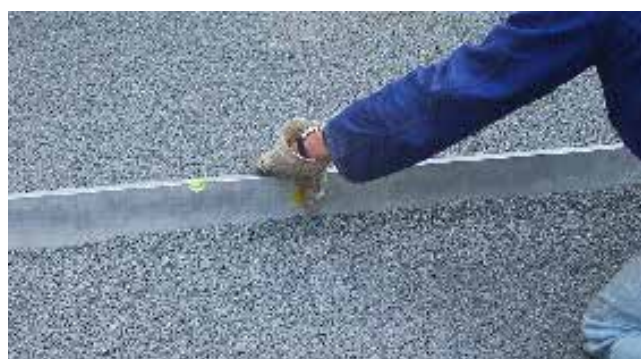
Figure 6 : nivellement du lit de pose
