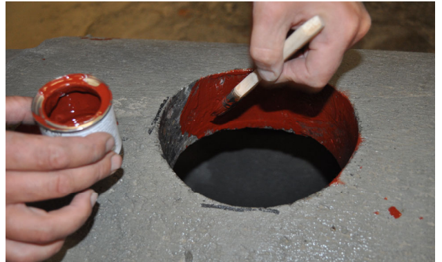
Bild 10: Auftragen von DENSONOX GV auf Bohrlochwandung
