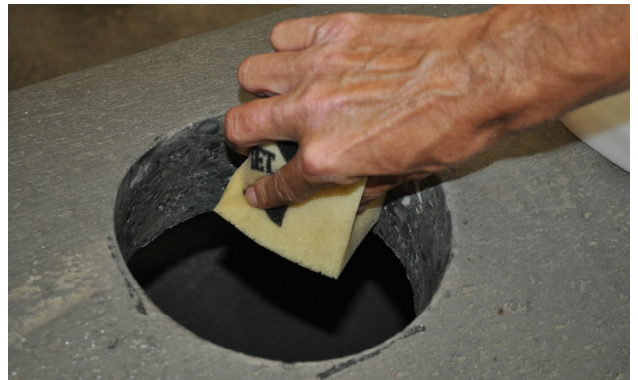
Bild 8: Bohrlochwandung mit Wasser befeuchten
