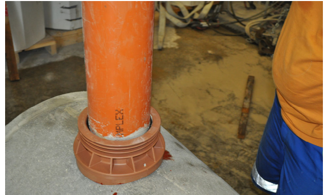
Bild 14: Anschlussrohr anschliessen
