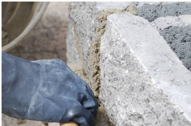
Bild 46: Modellieren der Fuge
