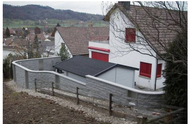
Bild 2: Doppelspaltsteine, eingesetzt als freistehende Mauer
