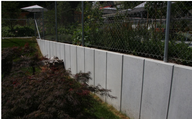
Bild 36: Mögliche Bepflanzungen im Bereich von Winkelplatten
