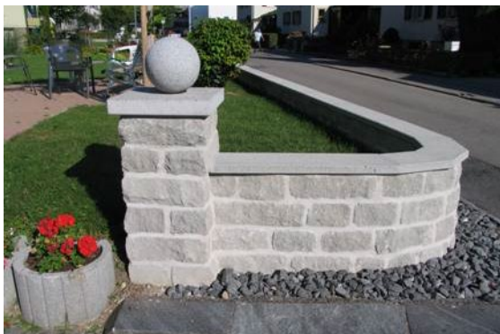
Bild 44: Versetzte SANTURO® Abdeckplatten in Segmente geschnitten
