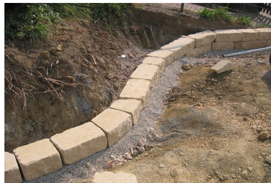
Bild 24: Versetzte erste Steinreihe in Kiesfundament
