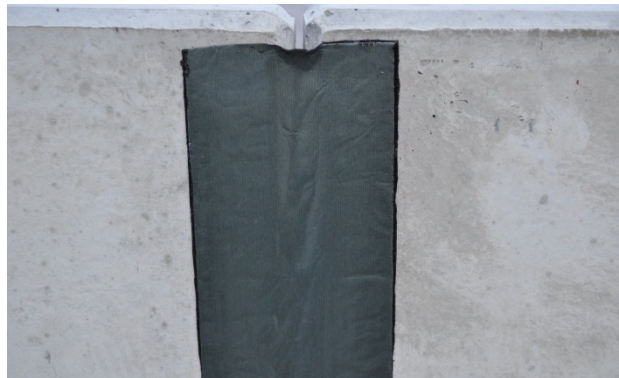
Bild 27: Abdichten der Fugen
