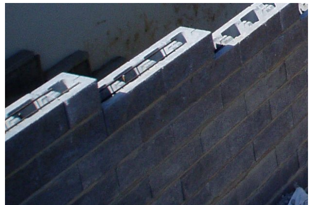
Bild 49: Bewehrungseinlagen, eingelegt in die vorgesehene Nuten
