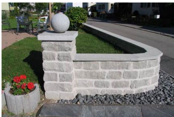
Bild 44: Versetzte SANTURO® Abdeckplatten in Segmente geschnitten
