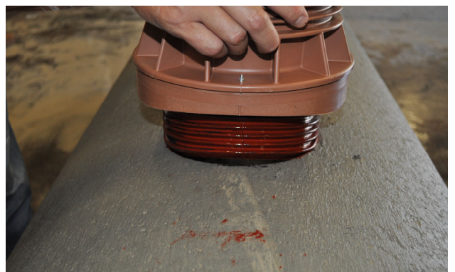
Bild 11: Steckanschlussstück ansetzen, Markierung beachten
