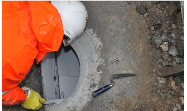
Bild 10: Klebmasse auf die Bohrlochwandung auftragen
