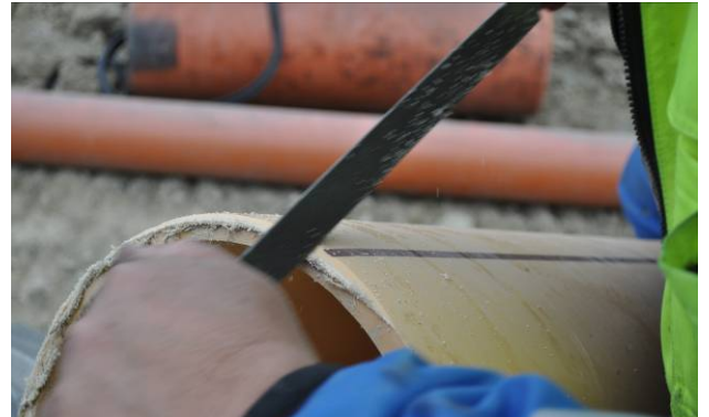
Bild 14: Anfasen des Kunststoffrohres, reinigen und einschmieren
