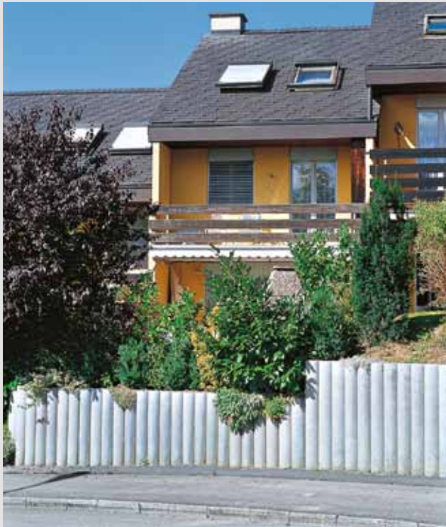
Beton-Palisaden als Hangsicherung.
