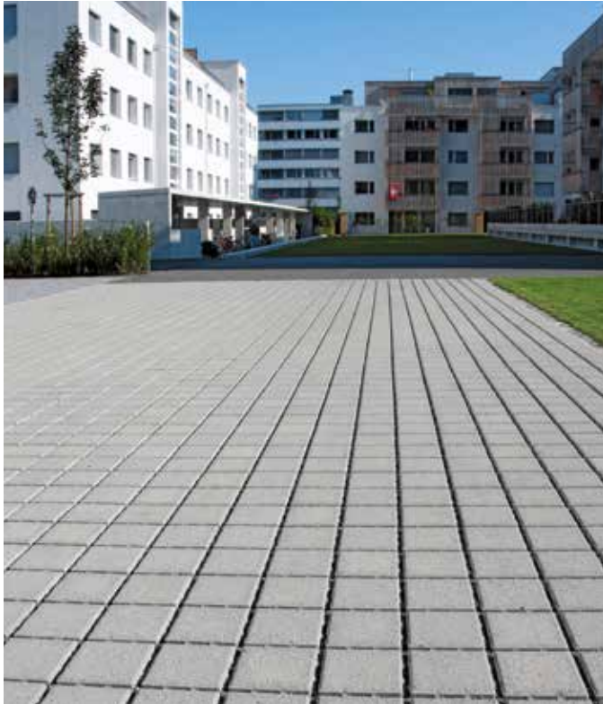
Parkfläche mit SPLITT Ökosteine
